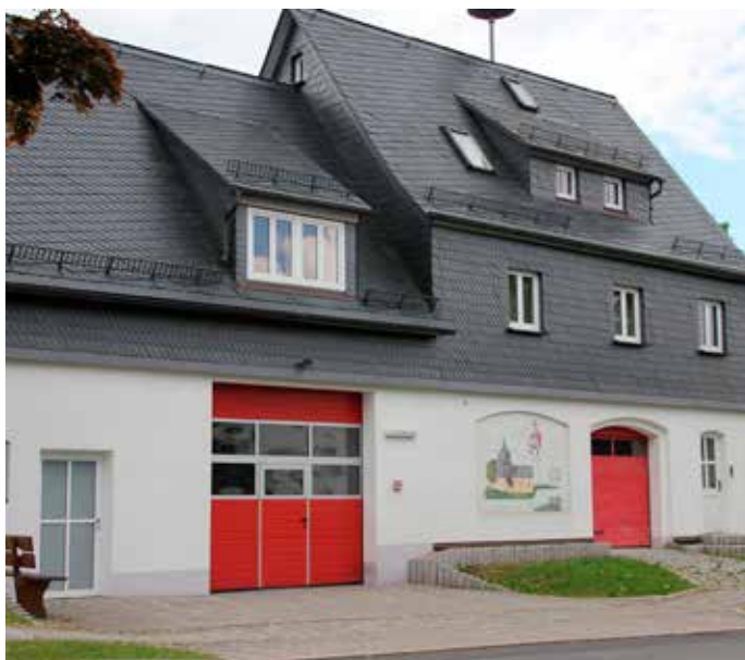
Das sanierte Feuerwehrhaus nach der Fertigstellung im Jahr 2013
