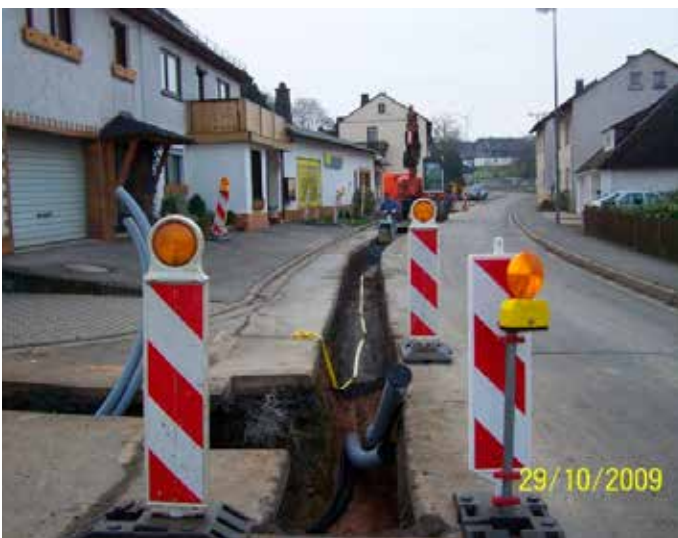
Die Arbeiten haben begonnen. Leitungsbau vor dem Dorfladen im Oktober 2009
