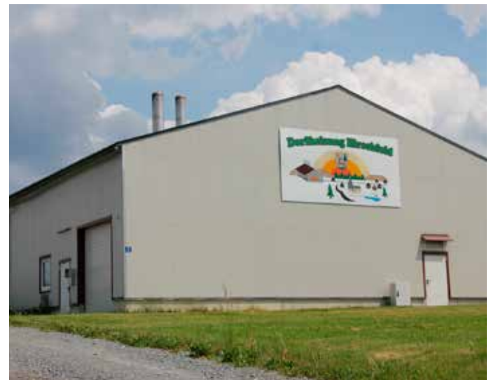
Das Heizwerk der Dorfheizung Hirschfeld
